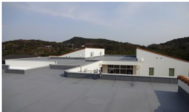
本館西側（屋上）
