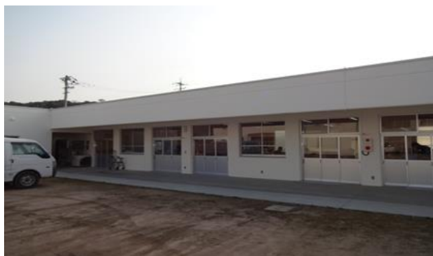
作業棟西側（外観）
